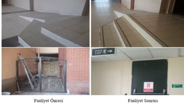
Şekil 4: Merdivenlere kaydırmaz bant uygulaması, acil çıkışların yeniden düzenlenmesi.
