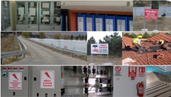
Şekil 5: Saha gözetimi sonrası uyarı levhalarının asılması, güvenlik işaretlerinin yerleştirilmesi.
