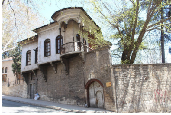
Şekil 20: Isparta Evlerinde Çıkma
