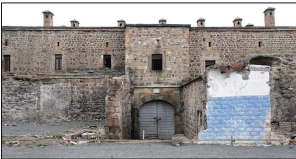
Şekil 2. Samsun Taşhan doğu (giriş) cephesi
