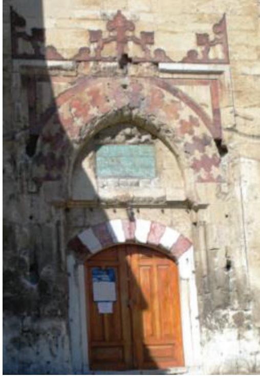
Fot. 24: Eski Camii batı cephedeki ta kapı. (Karanfil, 2009.)
