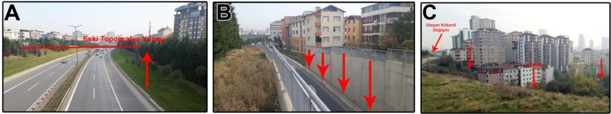
Foto 3. A) Otoyol Bağlantısındaki Rölyef Değişimi, B) Esatpaşa'da Ulaşım Kökenli Rölyef Değişimi, C) Aşık Veysel Mahallesi Yerleşim ve Ulaşım Kökenli Topografik Yüzeyin Değiştiği Sahalar
