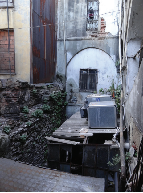
Fot. 8: Avlu ve Kapatılan Revak Kısımları
