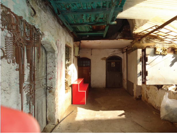
Fot. 14: İkinci Kat Revağında Odaların Girişi
