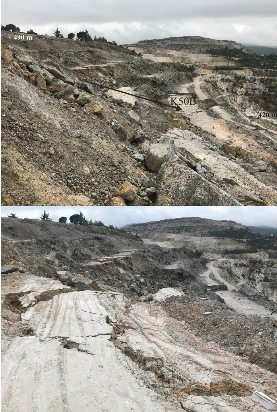
Şekil 1. Yenilme sonrası heyelan topoğrafyası (Foto:19.12.2018, sabah-7.30).
