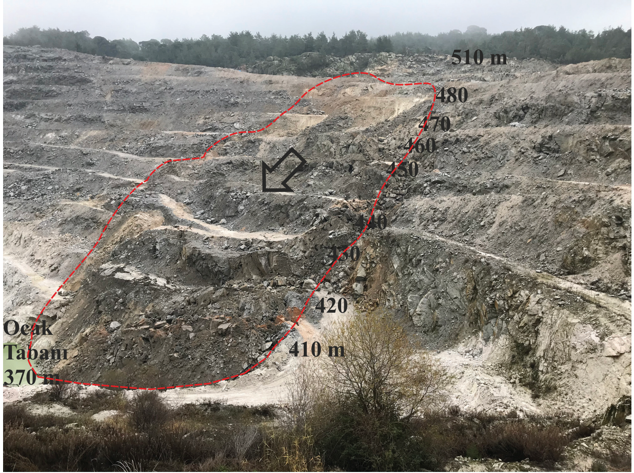
Şekil 12. Heyelan sonrası oluşan topoğrafya (19.12.2018, sabah: 7:30).
