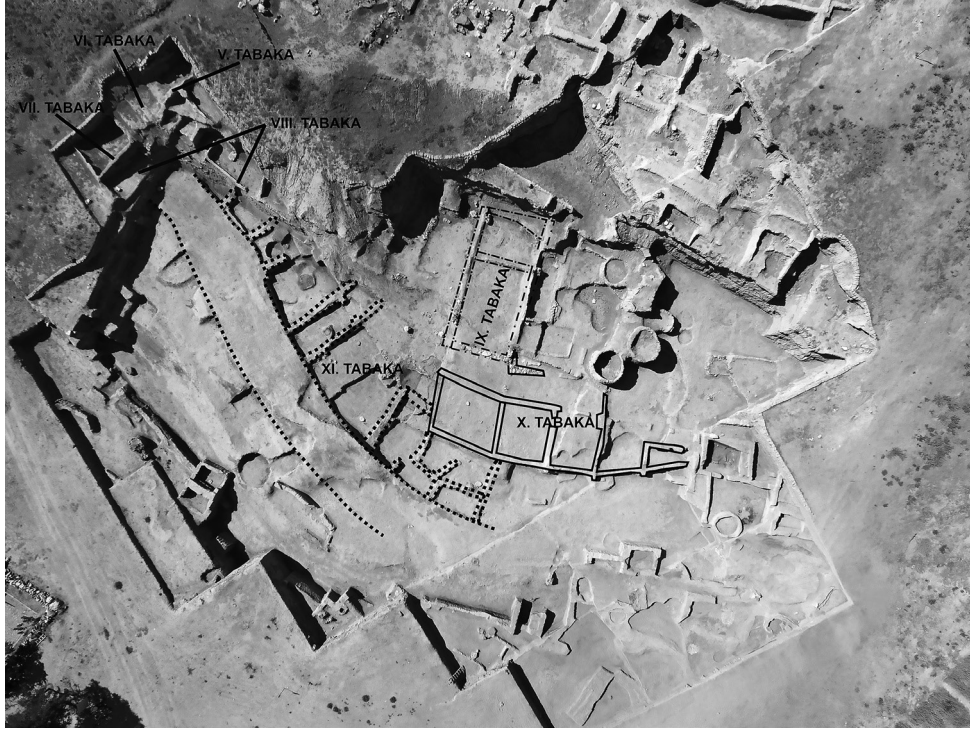
Res. 3 Acemhöyük Erken Tunç Çağı açmaları
