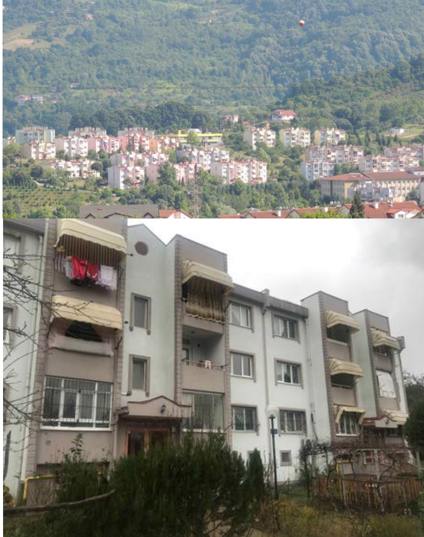
Şekil 4. Şirinköy Kalıcı Konutlarından bir görünüm (Uzuner Arşivi, 2019)
