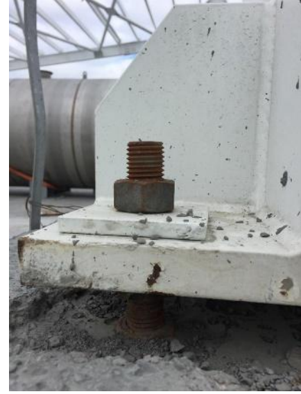
Şekil 1. Taban levhasının ankraj çubuğu ile bağlantısı için kullanılan ek levha
