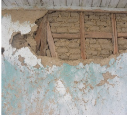
Şekil 10. Kerpiç tuğla dolgulu duvar (Fot.:Hüseyin Bayraktar)
