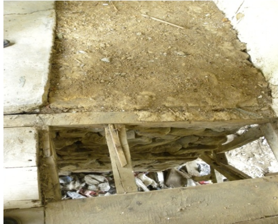
Şekil 31. Ocak temel taşlarının bittiği yer toprak örtülü, üstten görünüm (Fot.:Hüseyin Bayraktar)
