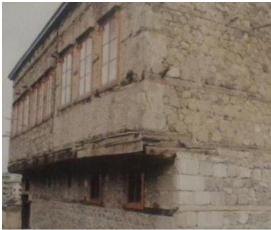
Şekil 9: Erzurum Evlerinde Çıkma ve Kontlar (Erzurum Çevre ve Şehircilik İl Müdürlüğü Arşivi)
