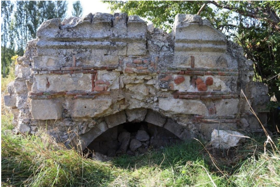
Fotoğraf 3: Taş Çeşme'nin kuzeydoğu yöndeki ön cephesi
