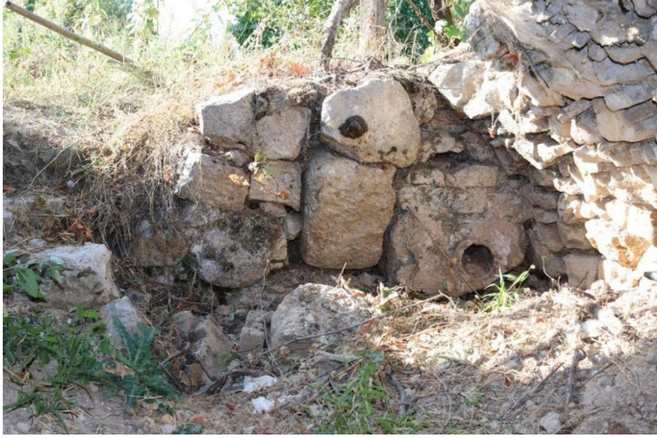
Fotoğraf 6: Çeşmenin arka cephesi ve sol alt köşede suyun aktığı pişmiş toprak künk
