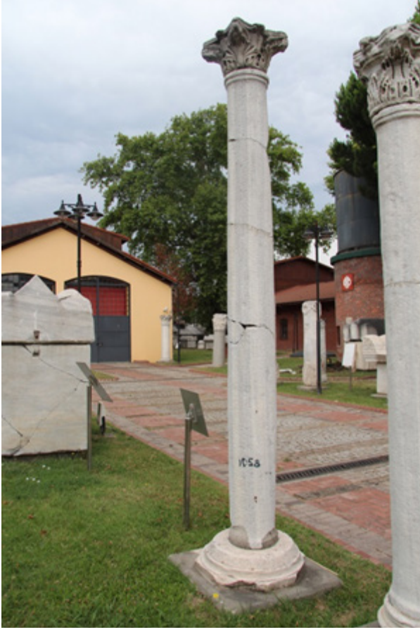
Figür 11. 1999 depremi sırasında 5 parçaya ayrılan sütunun restorasyon görmüş hali
