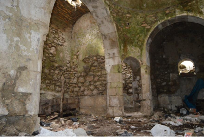
Fotoğraf 9. Sol(Güney) tonozlu bölüm
