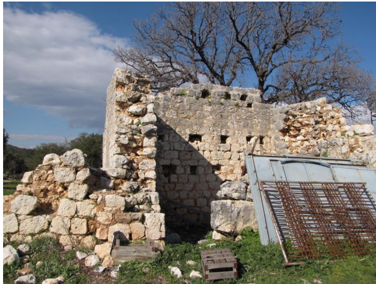
Res. 17. Mezgıt Kale, Silifke ilçesi, mimari yapı kalıntısı, doğa ve insanın tahribat izleri (L. Yılmaz, 2019)
