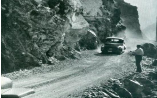
Ek 7. Artvin-Erzurum Karayolu'nun Çoruh Nehri Kenarından Geçen Bir Güzergâh
