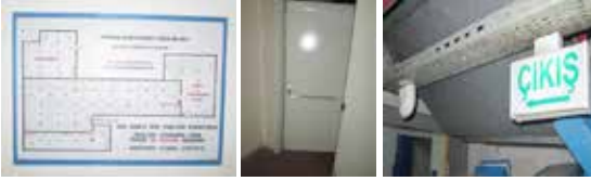
Şekil 10: Tahliye yönelik kat planı (solda), acil çıkış kapısı (ortada), acil çıkış yön levhası (sağda).
