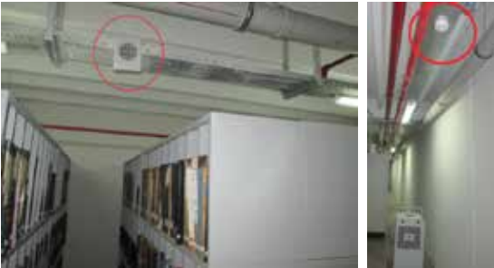
Şekil 11: Anons sistemi (solda) ve duman algılama sensörü (sağda).
