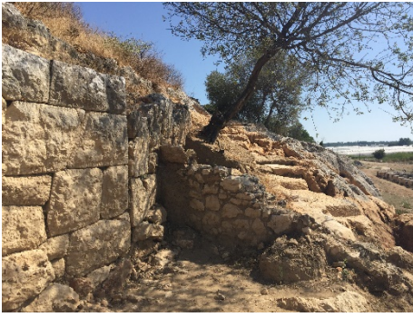
Fig. 11. Teras Duvarları ve Kaya Basamaklı Sunu Alanı (B. Özdilek)
