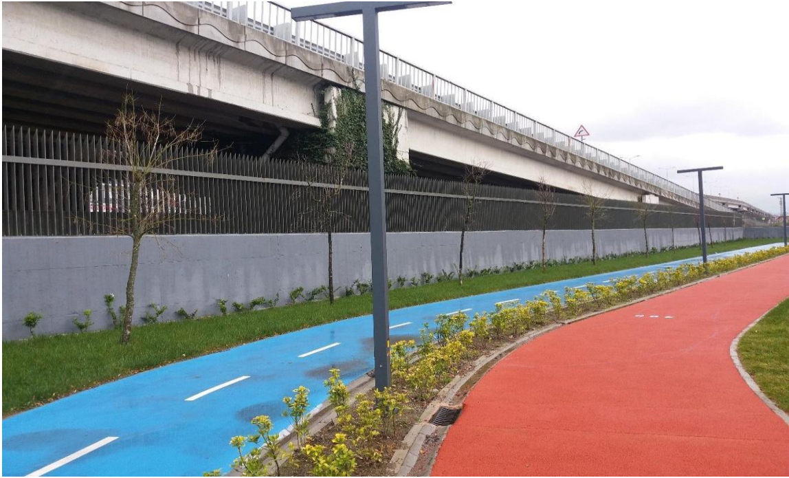
Şekil 7. Kot Farkına Karşı Yapılan İhata Duvarı
