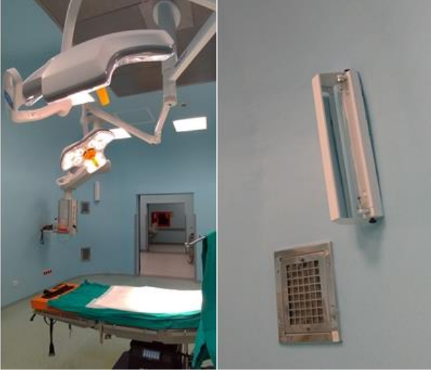
Şekil 12. Ameliyat lambası, UV armatür ve emiş menfezi detayı
