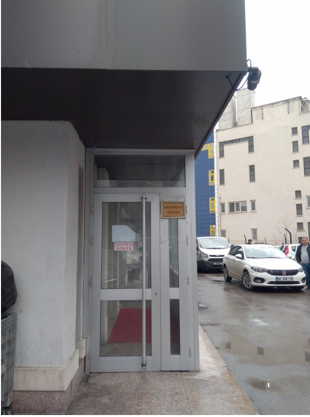
Fotoğraf 5: Ankara Adliyesi Balgat Ek Bina Girişi
