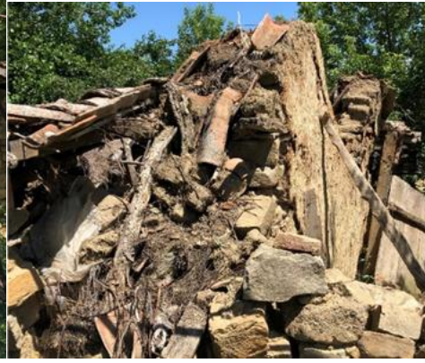
Şekil 3 b. Duvar örgüsünde toprak dolgu
