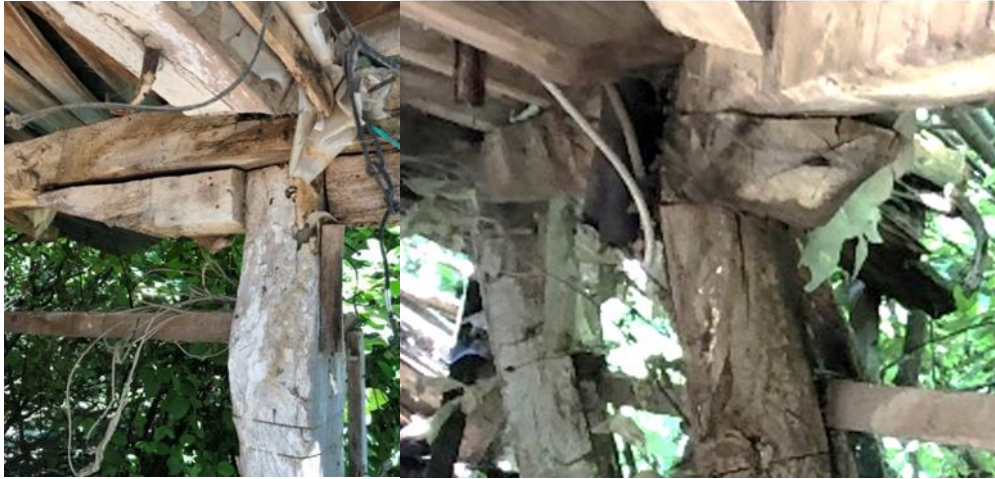
Şekil 7 a. Dikme aşık desteği
