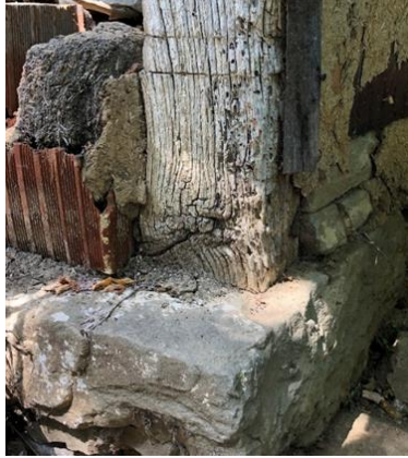
Şekil 9 a. Dikmenin taban birleşim detay fotoğrafı
