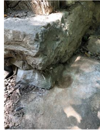
Şekil 11 b. Taban taşında silindirik oyuk
