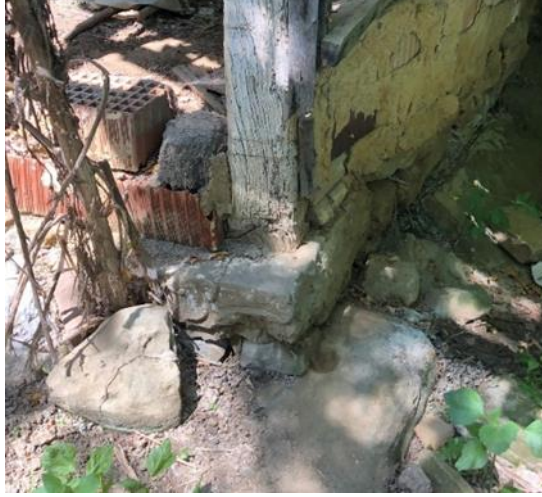
Şekil 8. Dikmenin zemindeki taşa oturtulması ve zemine yük aktaran daha büyük boyutlu taş
