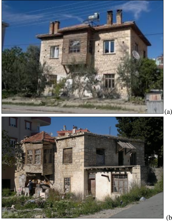
Şekil 3.15. (a) 3 ve (b)1 numaralı yapının güneybatı cephesi (Southwest facade of the building numbered (a)3 (b)1)
