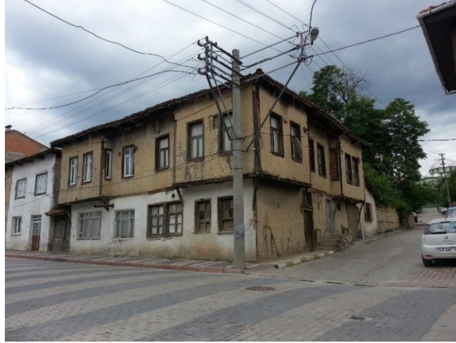
Şekil 3: Remzi Bey Konağı (Güneş Kaya Arşivi, 2016).
