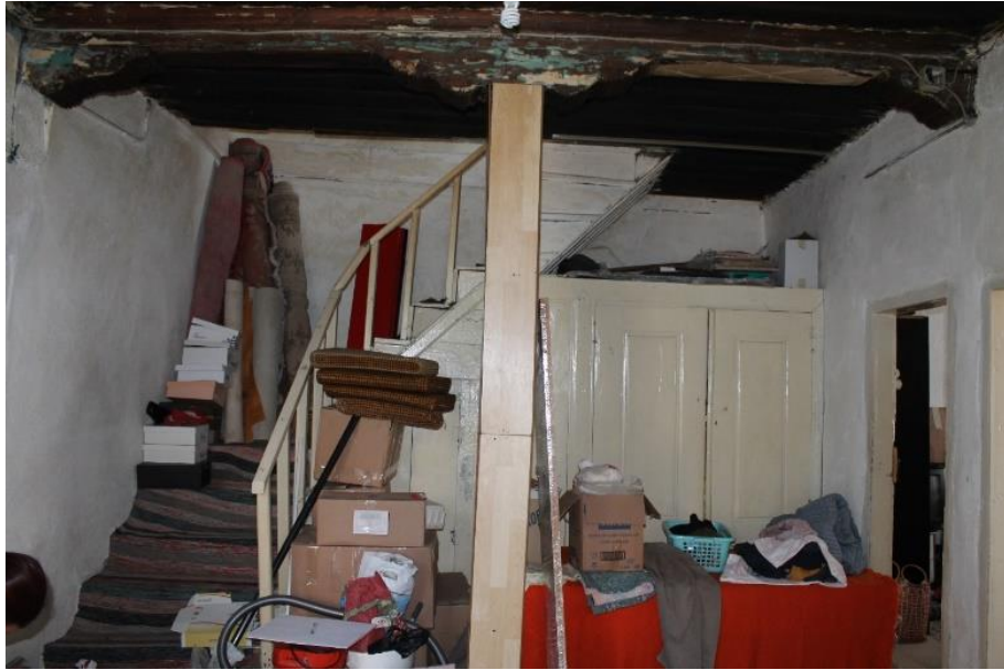
Şekil 13: Yapıya sonradan eklenen merdiven, 2016 (GTÜ Restorasyon Arşivi).
