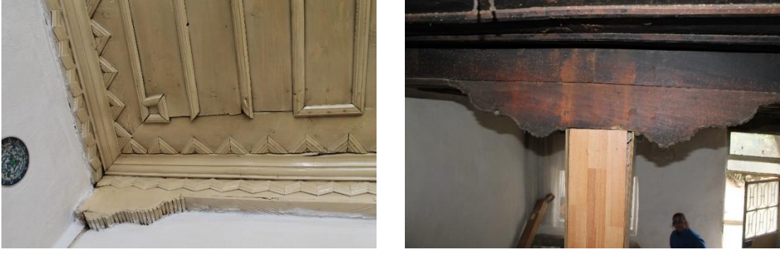
Şekil 16: Altında duvarın içinde kalan ahşap dikmenin başlığı ile birlikte tavan silmesi ve açıktaki ahşap başlıklara birer örnek (GTÜ Restorasyon Arşivi, 2016).
