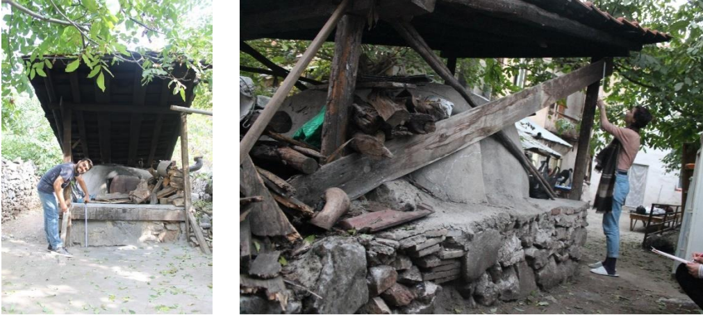
Şekil 11: Yapının bahçesindeki fırın (GTÜ Restorasyon Arşivi, 2016).
