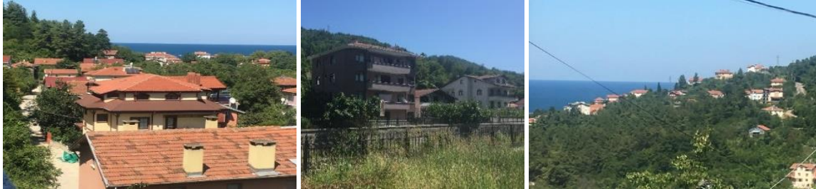
Şekil 7. Gemiciler Köyü yüksek katlı yapı örneği.
