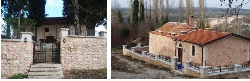
Şekil 12. İlyasbey Köyü Köy Camisi ve Hamamı 12 .
