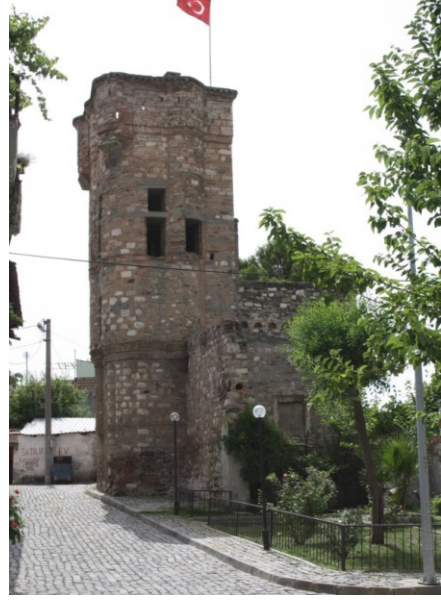
Fotoğraf 2. Cihanzâde Kulesi Doğu Cephe
