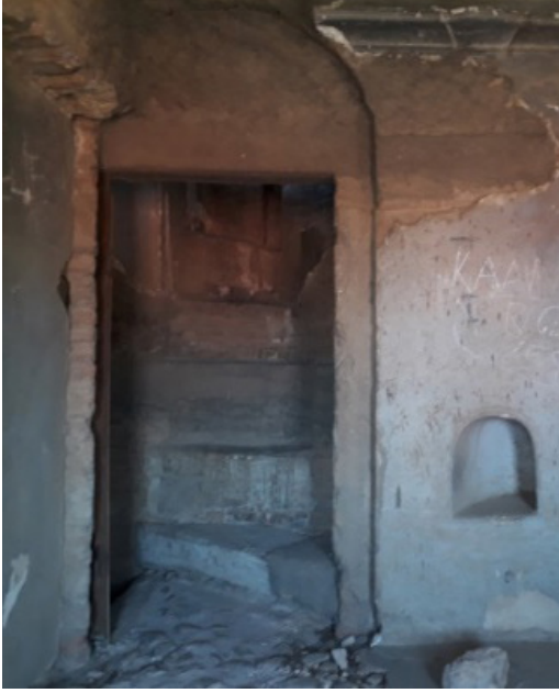
Fotoğraf 11. İkinci Kat Yazlık Oda Güney Duvarı
