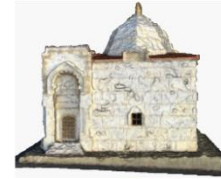
Aşık Paşa Türbesi, Kırşehir
