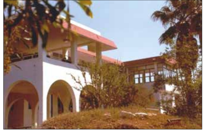
Fotoğraf 13. Yapıya eklenen teras (Can GİRGIN arşivi) / Terrace added to the building
