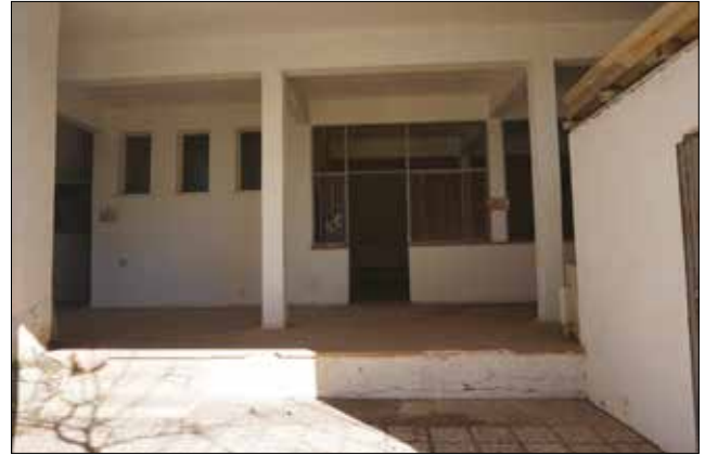
Fotoğraf 19. Umumi mutfak girişine eklenen doğrama (Uçar, 2020) / Joinery added to the kitchen entrance
