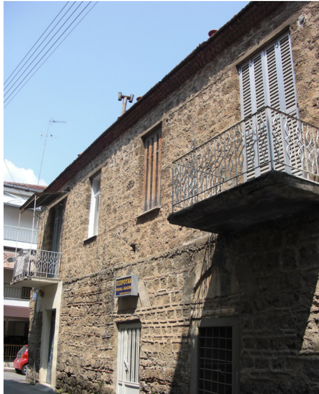
Resim-30 Karaferye Subaşı Camisi'nin batı cephesi görünüşü (Foto: Neval Konuk, 2008)
