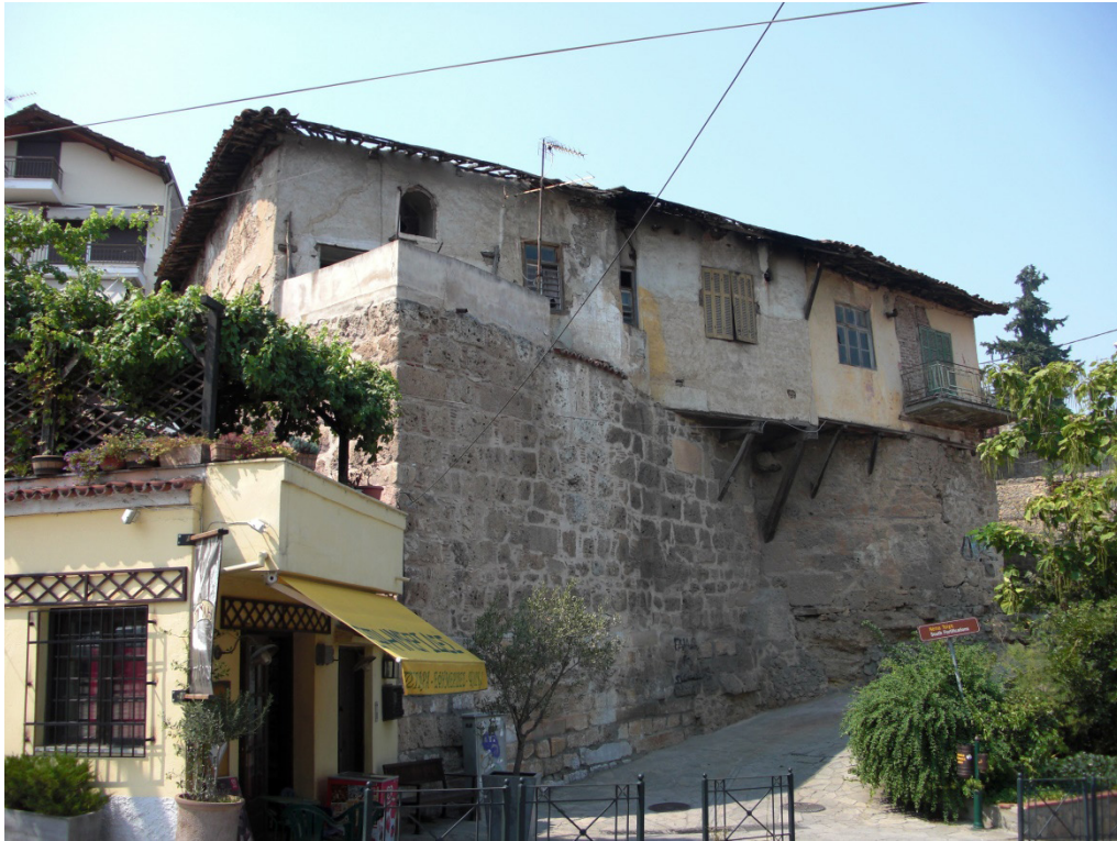
Resim 20. Karaferye Mahmud Çelebi Camisi'nin yol üzerinden güney (kıble) cephesinin genel görünüşü (sol köşede, Foto: Neval Konuk, 2008)
