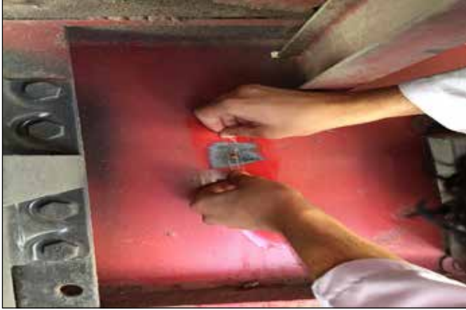
Şekil 7. Gerilim Ölçerlerin yapıştırma işlemi.
