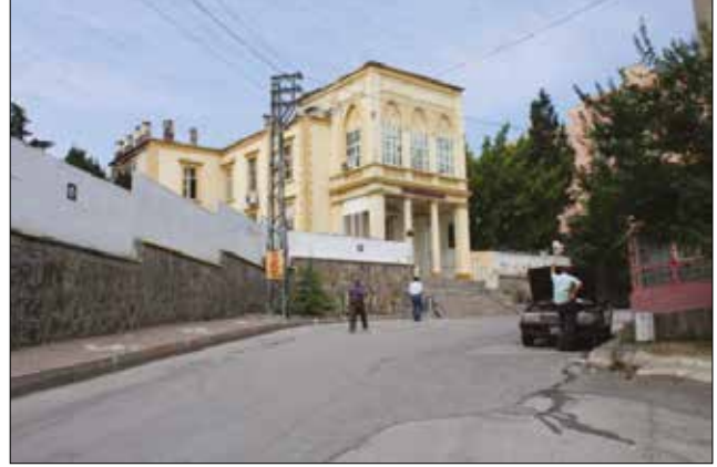
Fotoğraf 2. Hastanenin doğu cephesi /The East facade of the hospital. (N. Yazıcı, 2009)
