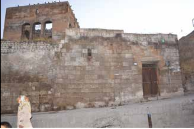
Fotoğraf 32 - 216 ada 3 parsel (Foto.: H.Kübra İlhan) / Block no: 216 / Lot no: 3.
