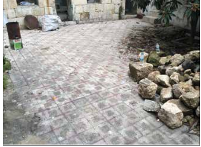
Fotoğraf 22. Avlu zeminine uygulanan karo mozaik (Yazar, 2016). / Tile mosaic applied to the courtyard.
