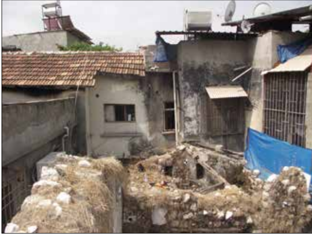
Fotoğraf 15. Cumhuriyet Dönemi'nde oluşan düşey katmanlaşma. Yapı, yakın çevresindeki betonarme kütle ekleriyle sarılmış durumda (Yazar, 2016). / Vertical stratification in the Republican Period. The building is surrounded by reinforced concrete structures.
