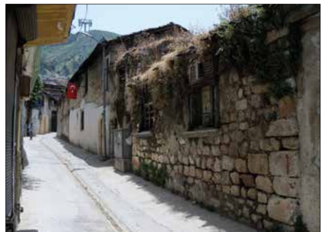
Fotoğraf 4. Yapının Alaybey Sokak cephesi (Yazar, 2017). / Alaybey Street facade of the building.
