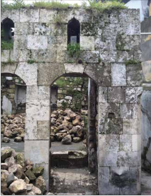
Fotoğraf 11. Avluda bulunan kütlelin girişi ve köşe pahı (Yazar, 2017). / The entrance and the corner chamfer.
