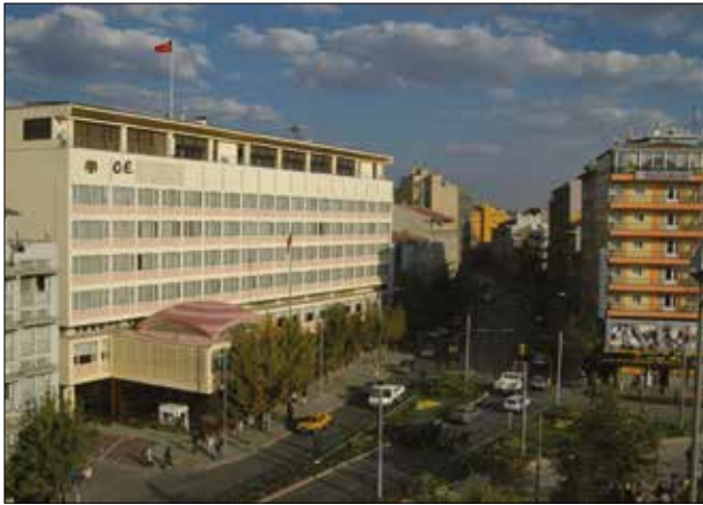
Fotoğraf 3 - Porsuk Oteli (Subay Orduevi) (Eskişehir Modern Mimarlık Mirası Sergisi). / Porsuk Hotel (Officers' social center)(Eskişehir Modern Architecture Exhibition)
