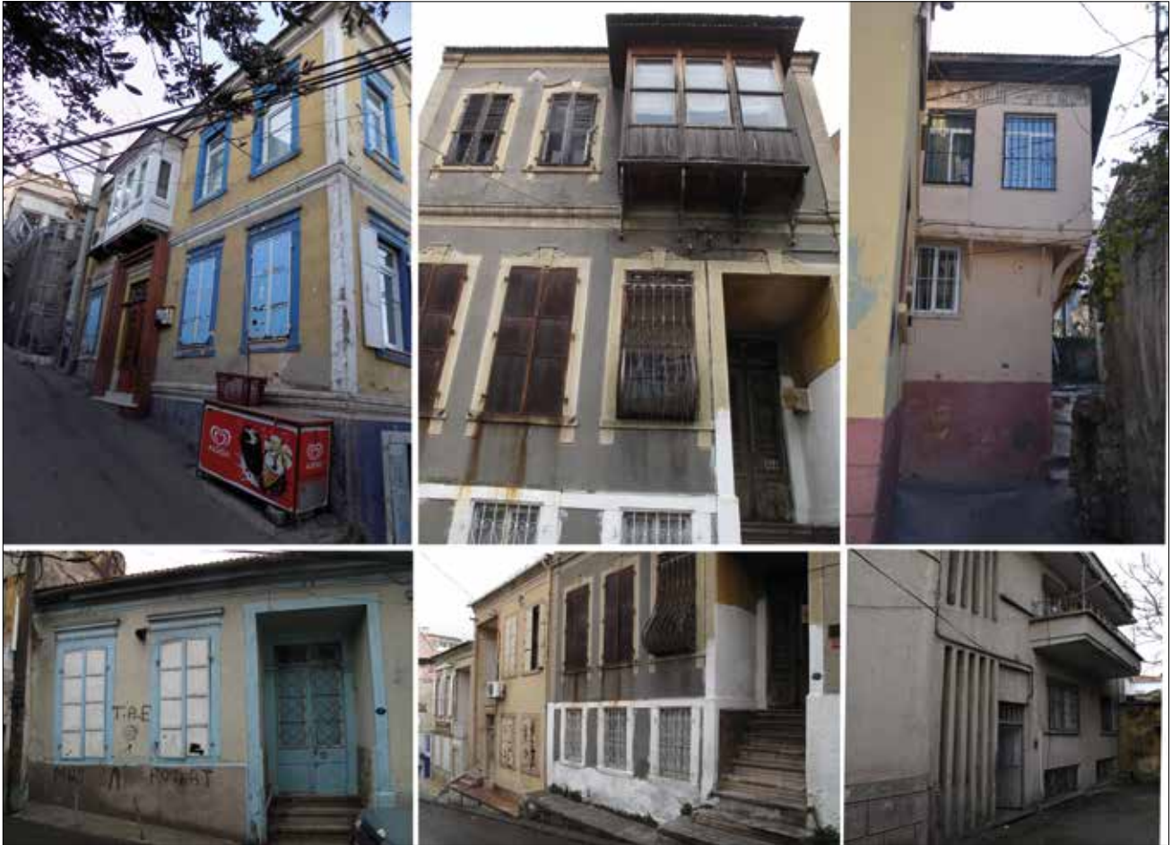
Şekil 3 - Patlıcanlı yokuşu üzerindeki yapılardan fotoğraflar. / Images from the buildings that locates on Patlıcanlı Yokuşu.
