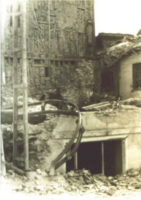
Res. 1. Depremde hasar gören elektrik direkleri ve telleri gibi altyapı elemanları.
