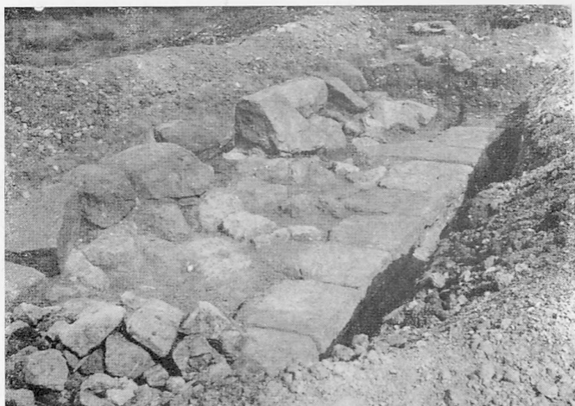
a. Soubassement de muraille à Daskyleion (Epoque archaïque).
