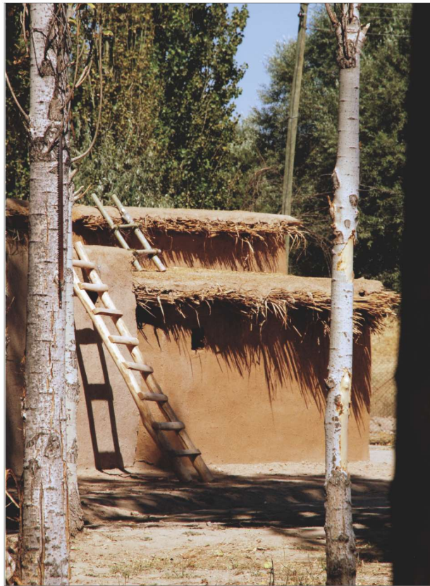
Res. 12. Kerpiç binaların olası dam açıklıklarına ahşap merdivenler yardımıyla giriş
