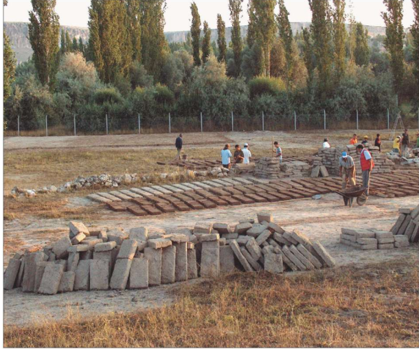
Res. 10. Kerpiç yapımı ve blokların kurutulması
