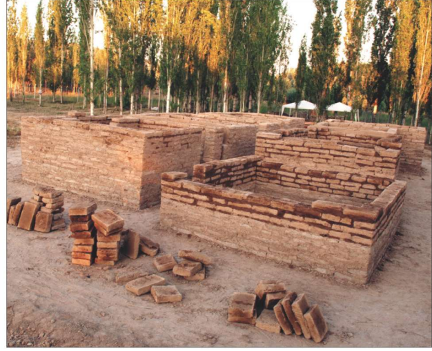
Res. 11. Kerpiç bina yapım süreci
