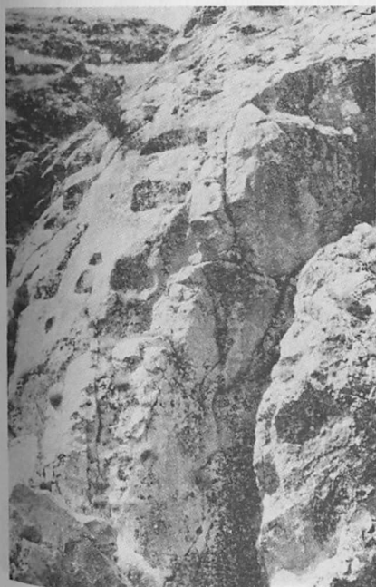
Abb. 2b Mauerauflager mit Bohrlöchern (Ambarlikaya)
