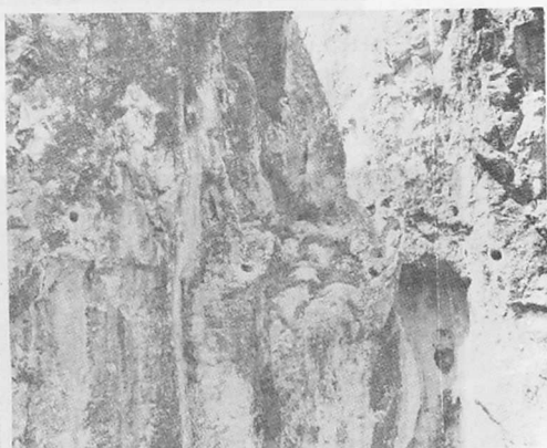
Abb. 4d Felsrinne für Wasserleitung
