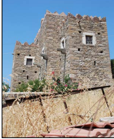
Fot. 5: Bodrum Ortakent’de bulunan kule ev - Mustafa Paşa Kulesi (F. Ceyda Güney, 2015)
