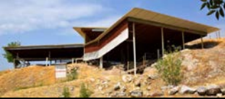
Arslantepe Höyüğü koruyucu çatısı (Yollardan, t.y)
