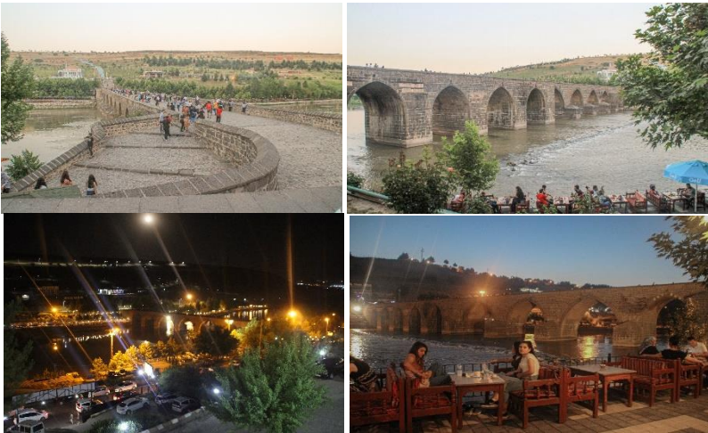
Resim 19. Köprü'nün restorasyon sonrası gece görünümü (Demir 2021).
