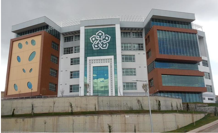
Resim 2. NEÜ Fakülte Binası Ön Cephe Görünümü
