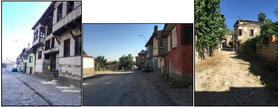
Fotoğraf 8- Restorasyon ihtiyacı olan yapılara örnekler Photo 8- Examples of buildings need restoration
