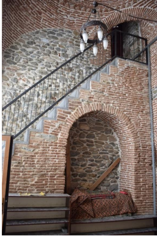
Resim 8. Muş Ulu Camii Minare gidiş merdiveni
