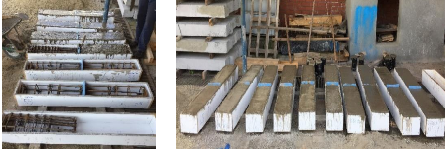
Şekil 3. Bazı numunelerin beton dökümünden önceki ve sonraki durumları
