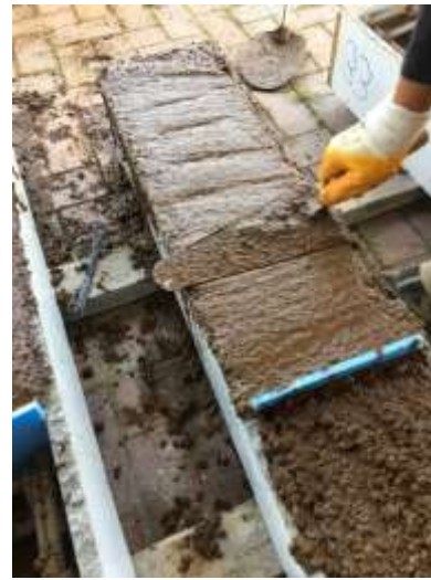
Şekil 3. Beton yerleştirme ve mastarlanma anı Figure 3. Place of concrete and leveling time
