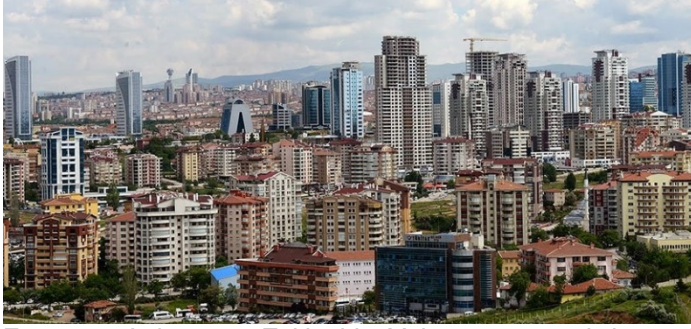
Fot. 11: Ankara – Eskişehir Yolu ve çevresi kentsel parçalanma (URL-7)
